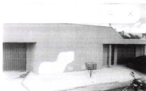
Rua da Glória, 30 - Cidade dos Funcionários
