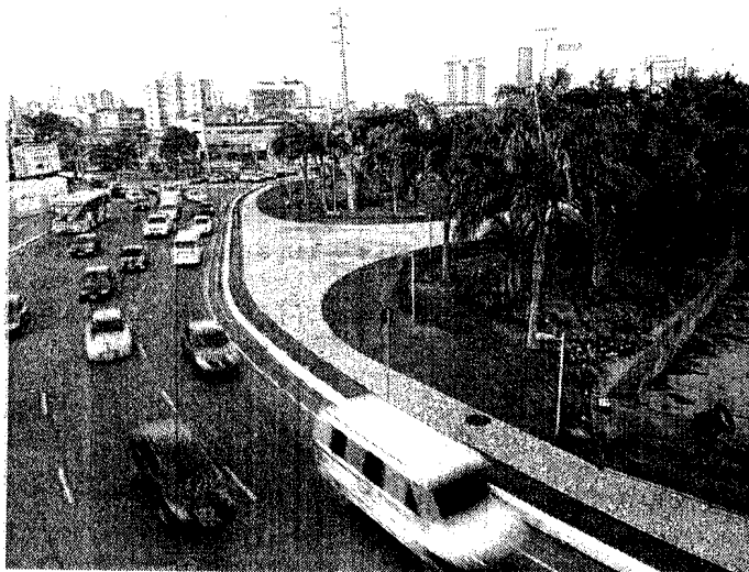
O novo viaduto está previsto para ser construído por cima da rotatória da avenida Aguanambi, no sentido Centro-Messejana
